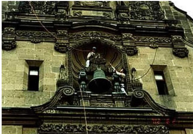
El contrapeso de madera se encuentra conformado por tres secciones, la primera sección tiene dimensiones promedio de 0.525 x 0.50 x 0.265 M., la segunda sección tiene dimensiones promedio de 0.80x 0.298 x 0.265 M. y la tercera tiene dimensiones promedio de 1.275 x 0.505 x 0.265 M. sobrepuestas una a la otra y zunchadas con hierro forjado.
