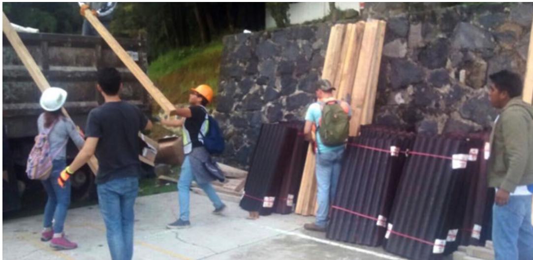
Trabajos de apoyo con entrega de material para la reconstrucción temporal.
