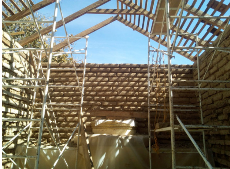
Imagen 6. Fotografía de integración de muro testero con sillares de adobe, “Capilla de San Agustín”, ubicada en el municipio de Tetela del Volcán, Estado de Morelos, Fotografía: CAV Diseño e Ingeniería S.A. de C.V.
