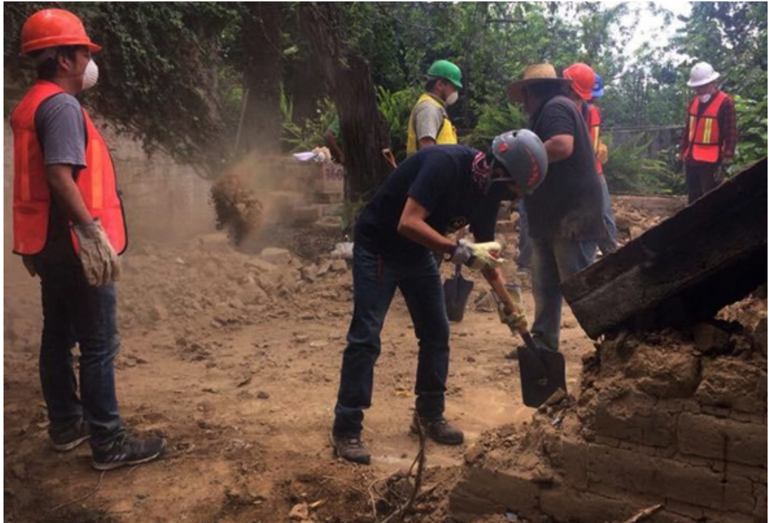
Trabajos de remoción de escombros.
