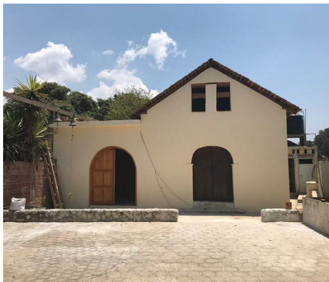
Imagen 9. Fotografía de fachada poniente posterior a nuestra intervención, "Capilla de San Agustín", ubicada en el municipio de Tetela del Volcán, Estado de Morelos, Fotografía: CAV Diseño e Ingeniería S.A. de C.V.
