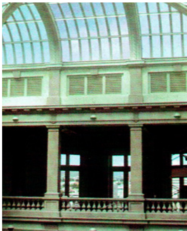
Lucernario en proceso de intervención.
