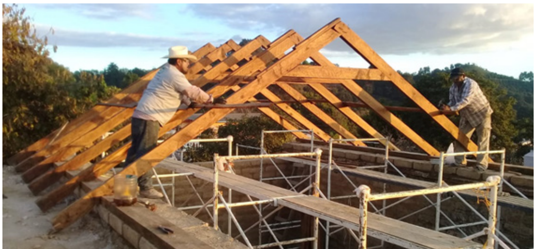
Imagen 7. Fotografía de montaje de cubierta de madera, “Capilla de San Agustín”, ubicada en el municipio de Tetela del Volcán, Estado de Morelos, Fotografía: CAV Diseño e Ingeniería S.A. de C.V.
