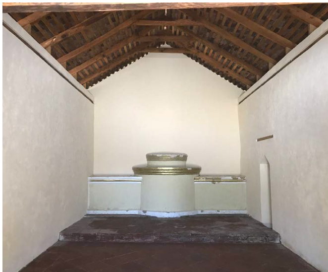
Imagen 8. Fotografía de muro testero, muros interiores y cubierta al termino de nuestra intervención, "Capilla de San Agustín", ubicada en el municipio de Tetela del Volcán, Estado de Morelos, Fotografía: CAV Diseño e Ingeniería S.A. de C.V.
