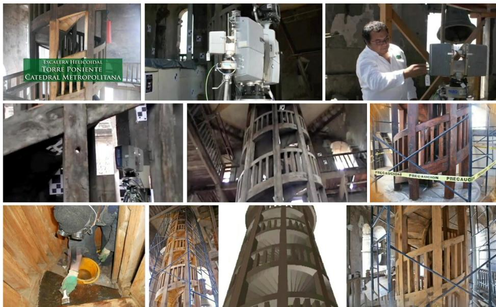
Imagen 2. Registro del proceso de registro con escáner láser 3D y trabajos de restauración de la escalera helicoidal de la Catedral Metropolitana. Trabajo realizado por CAV Diseño e Ingeniería en el año 2012.
