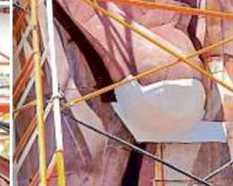
■ A partir de un dibujo de Siqueiros se proyectó la Cabeza de Juárez, hecha con láminas de acero. Se atienden daños en el metal.
